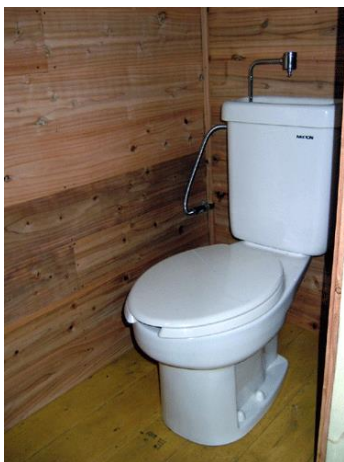
そして改装なったトイレです
