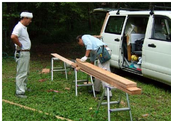
長井班はトイレの改修です
