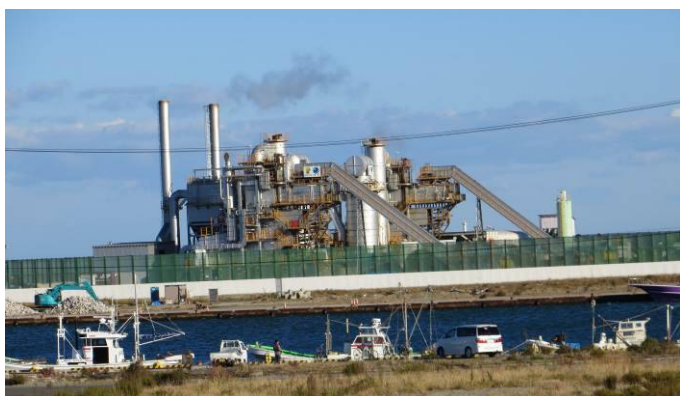
瓦礫わきに建設された焼却プラント（知られていない）
