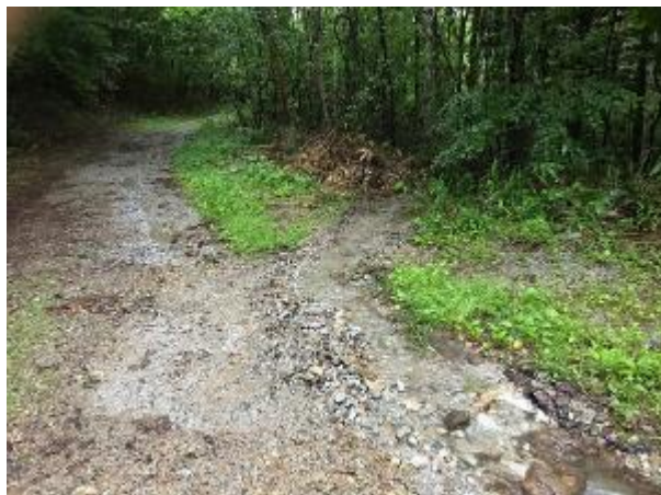
(湧き水と雨水で削られたひどく荒れた山道)
