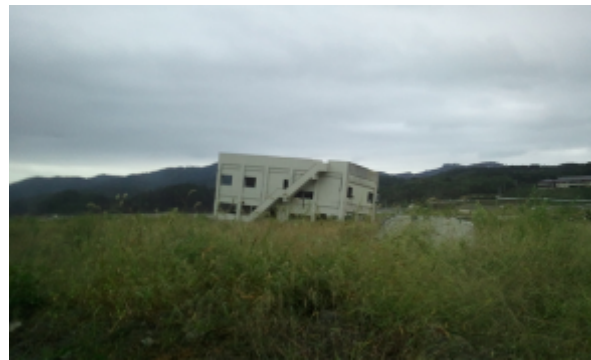
(土台が削られた3階建てのビル傾く)
